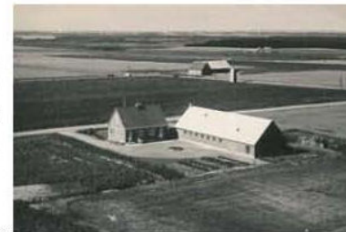
Ny oprettede statshusmandsbrug på heden
