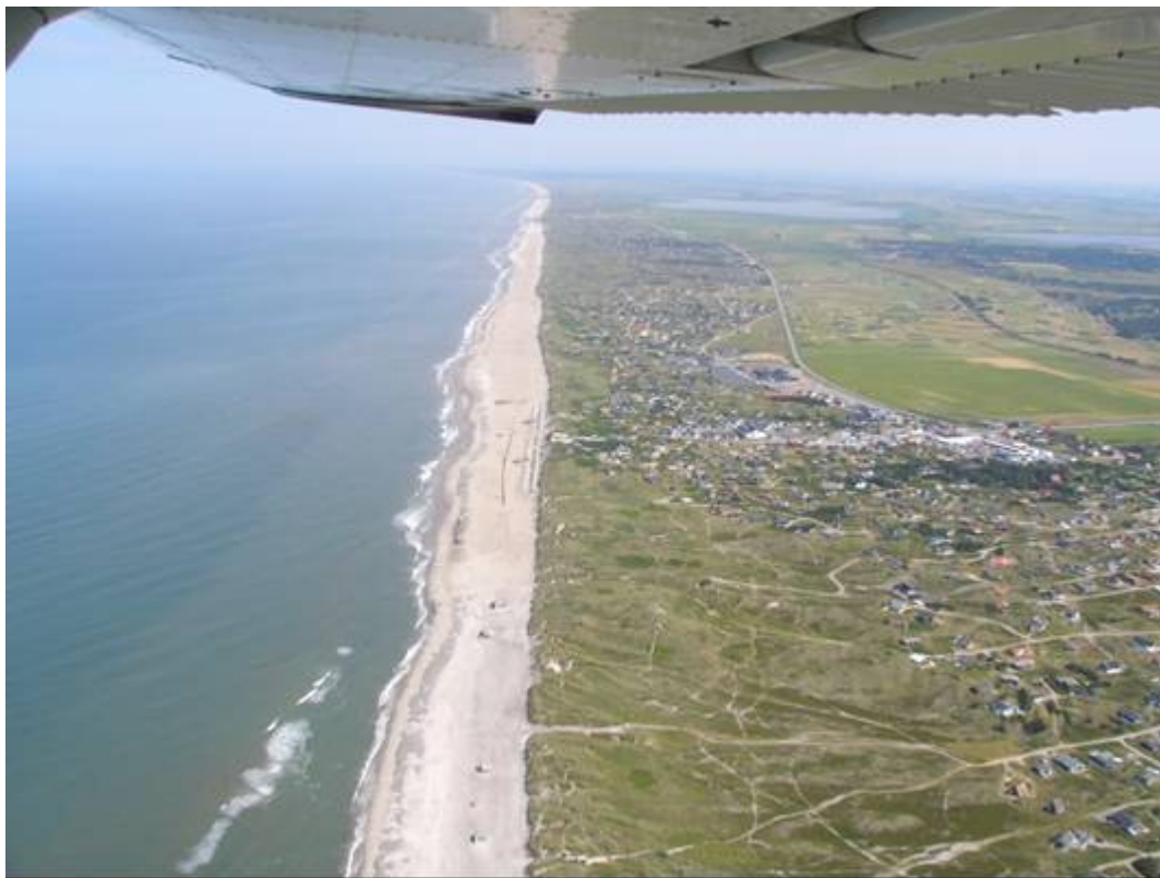
Sandfodring ved Søndervig d.5 juli 2005 efter sandfodring med 960.000 kubikmeter sand.
