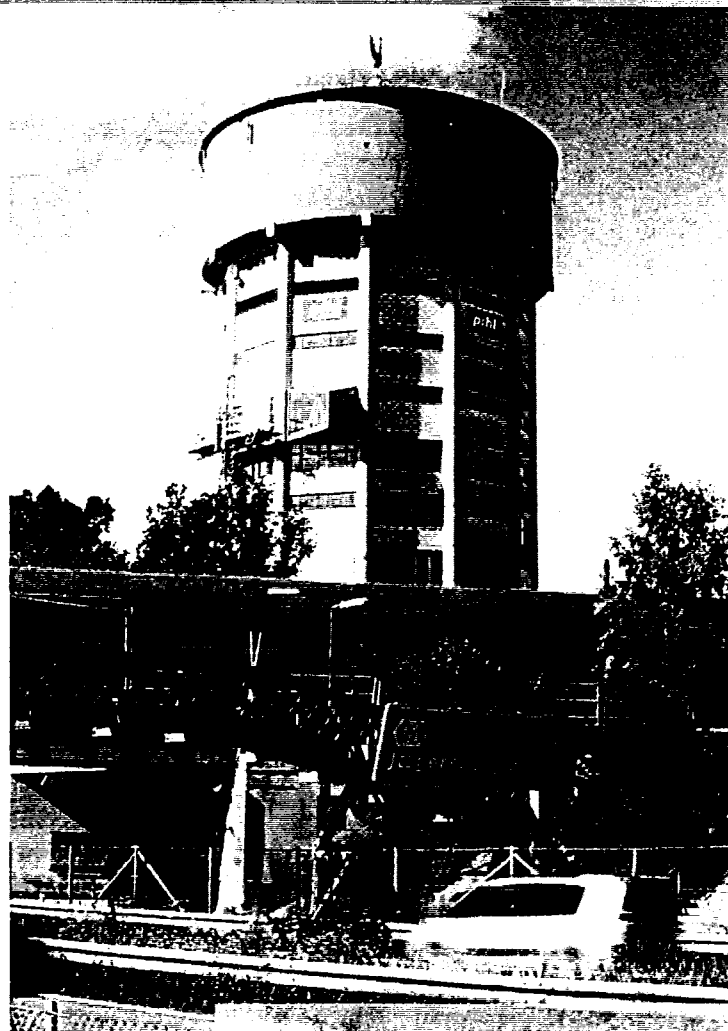
Helsingørmotorvejen, Motorring 3 og S-togsbanen giver et støjniveau ved vandtårnets facade på 76 dB(A).
