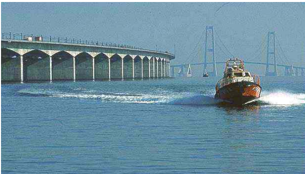
Afviserfartøj, VTS-system, Storebælt
