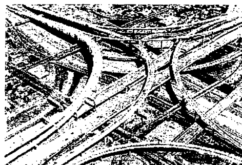
Motorvejskryds i Los Angeles. Krydsene er normalt i 4 etager med de fleste af ramperne bygget på søjler. (Krydset mellem Interstate 110 og Interstate 405).
