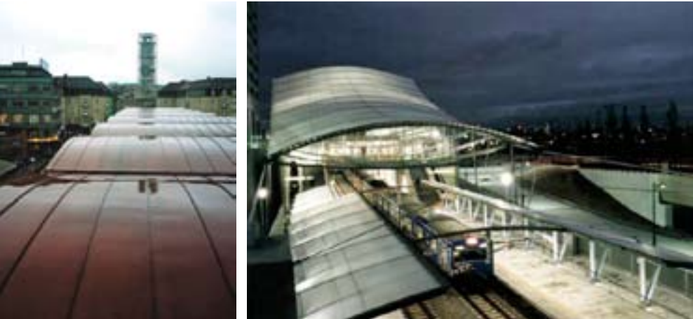
Kobbertag på Bruuns Arkade, Århus Perronoverdækning udført med plastdug, Osaka, Japan
