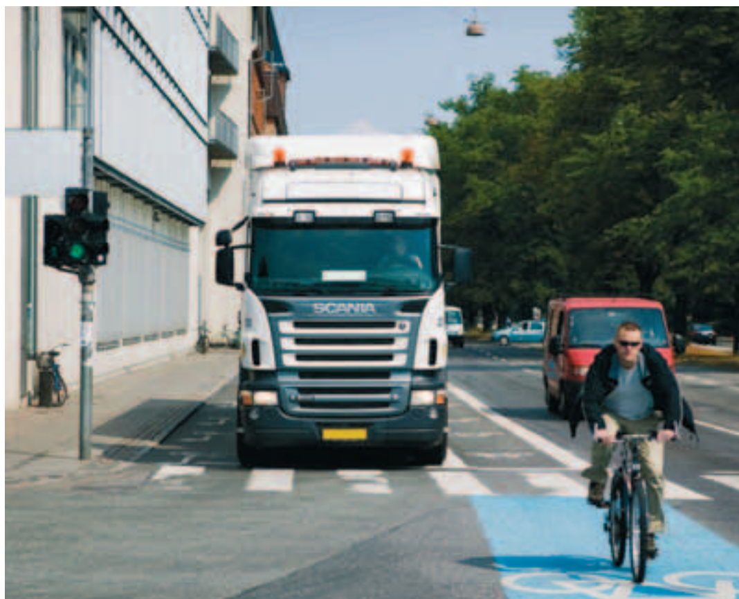
Billede 5.3: Cykelbane placeret mellem højresvingbane og ligeudbane i signalreguleret kryds. Ingen umiddelbar konflikt mellem højresvingende lastbiler og ligeudkørende cyklister
