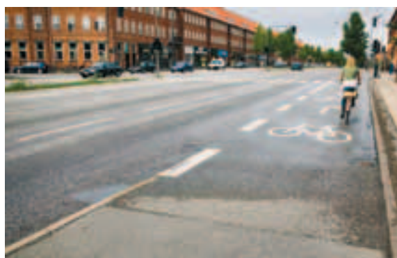
Billede 2.9: Afkortet cykelsti, som etableres ved at cykelstien eller -banen afbrydes i nogen afstand fra stoplinjen, hvilket vil muliggøre fletning mellem cyklister og højresvingende bilister i et kørsor afmærket med højresvingsspil
