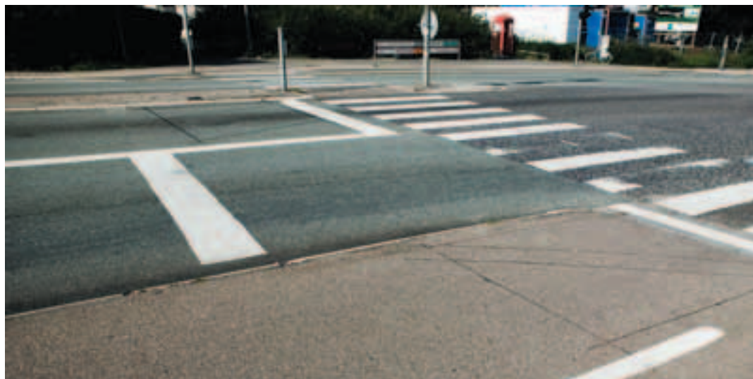
Billede 2.8: Tilbagetrukket stopstreg for biltrafikken etableret ved, at cykelstier og -baner er ført frem til stoplinjen kombineret med en tilbagetrækning på 5 m af stoplinjen for bilister. Cyklister får herved et forspring i forhold til den højresvingende biltrafik. Af hensyn til fodgængerens sikkerhed bør stopstregen trækkes tilbage i begge kørebaner
