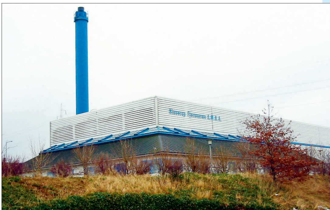
Hinnerup Fjernvarme a.m.b.a.: - systemet blev installeret og idriftsat ultimo september, 2004 Besparselsen i lednings tab i regnskab 04/05 (7 mdr. drift.) er 1.138 MWh. som = 153.585,-kr. med en kostpris på 135 kr./pr.MWh. Besparelsen i lednings tab i regnskab 04/05 (12 mdr. drift.) er 1.252 MWh. som = 168.975,-kr. med en kostpris på 135 kr./pr.MWh.
