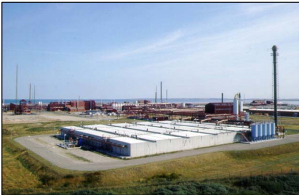
Biologisk rensningsanlæg på Rønland.
