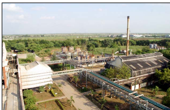
Produktionsanlægget for mellemprodukter i Panoli.
