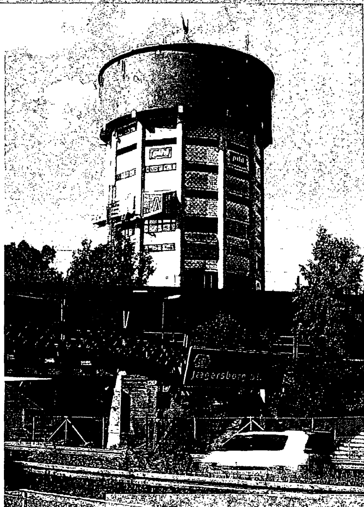
Helsingørmotorvejen, Motorring 3 og S-togsbanen giver et støjniveau ved vandtårnets facade på 76 dB(A).
