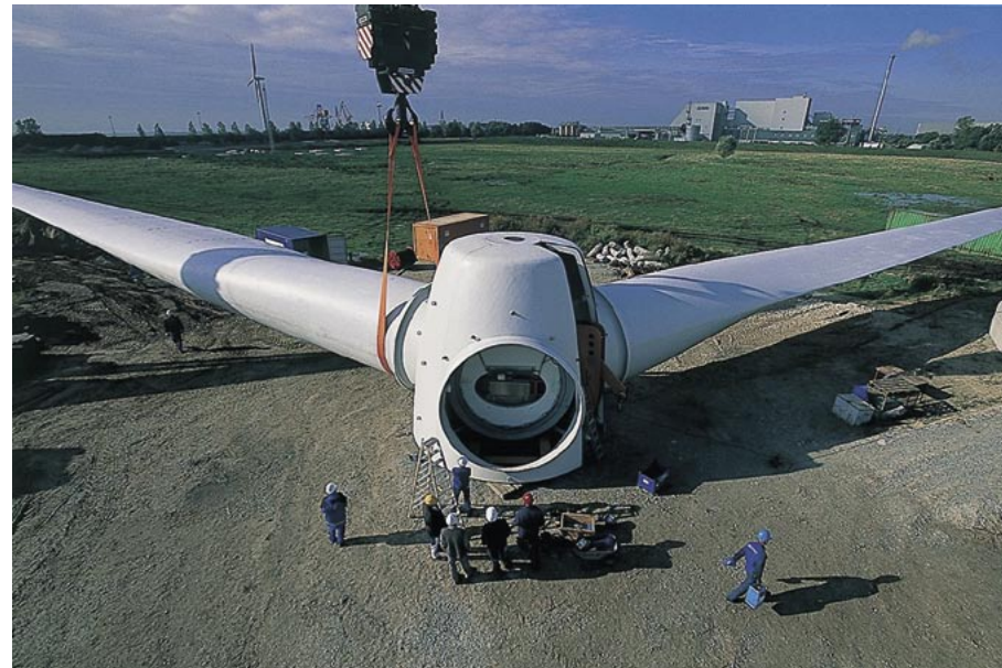
Arbejdsareal omkring vindmølle (Foto: LM Glasfiber)
