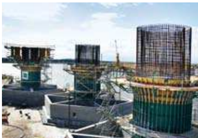
Fundamenter støbes og sejles ud fra Swinoujuscze i Polen
