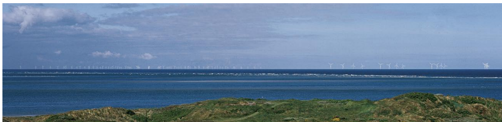
Eksempel 2. Udvidelse af eksisterende møllepark ved 'naboudvidelse'. 16 stk 15 MW møller, afstand omkring 18 km.
