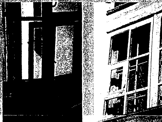
Flere åbninger i hhv. inderste og yderste vindue giver gode muligheder for udluftning, varmegenvindig og støjdæmpning.
