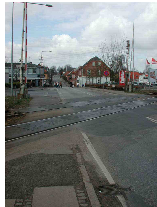
Overkørsel 110 centralt i Tølløse
