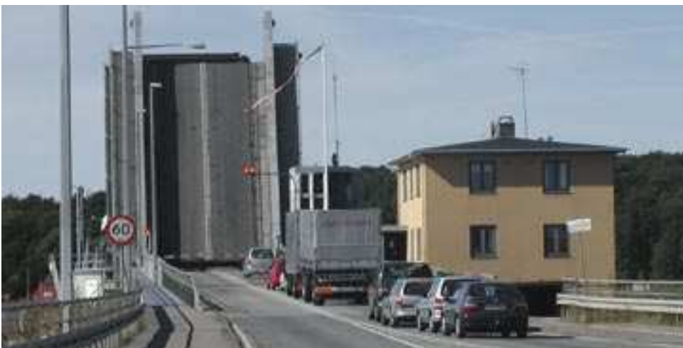
Figur 2.4 Kronprins Frederiks Bro er en klapbro, der tillader passage af skibe uden for vejtrafikkens myldretid.
