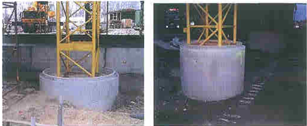
Figur 25 Placering af pæle og fundamenter for det østlige gennemkørselsfag har ikke kunnet konstateres.
