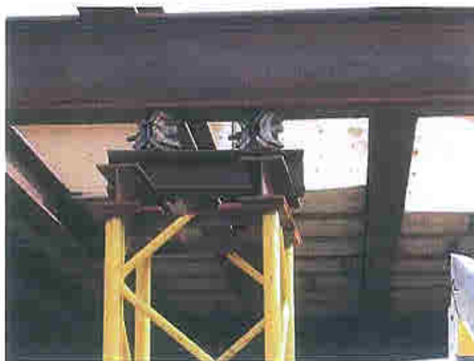
Figur 27 Opbygning af tårntop
