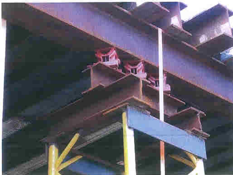
Figur 18 Overgangskonstruktion, opbygget af et system med 3 donkrafte hvilende af på en fordelingsdrager samt to åg. Nedenunder igen ses tårnet
