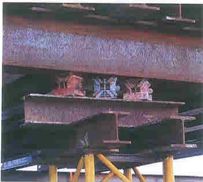
Figur 20 Udført overgangskonstruktion for tårn med 3 donkrafte
