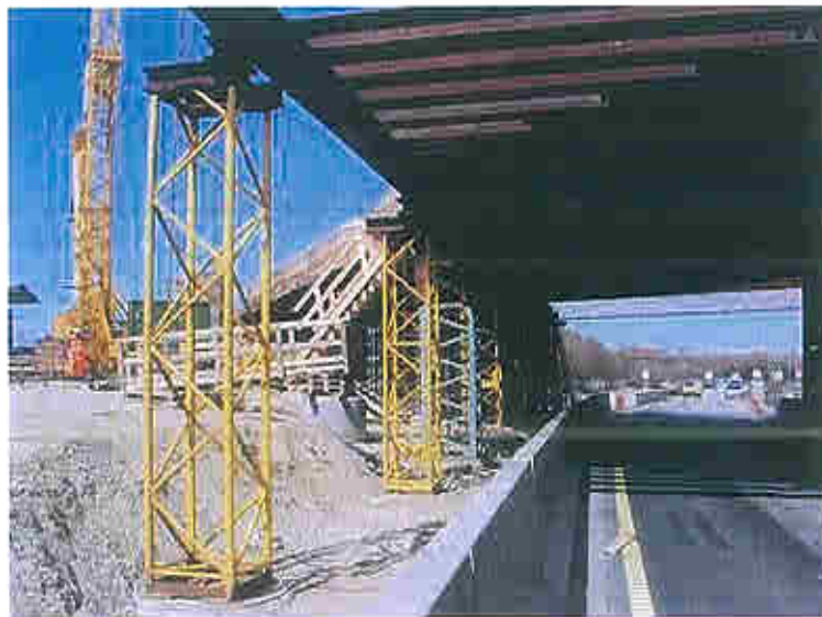
Figur 26 Placering af stilladstårne
