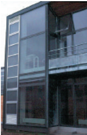
En solvæg kan varme ventilationsluften op, Økohus i Kolding
