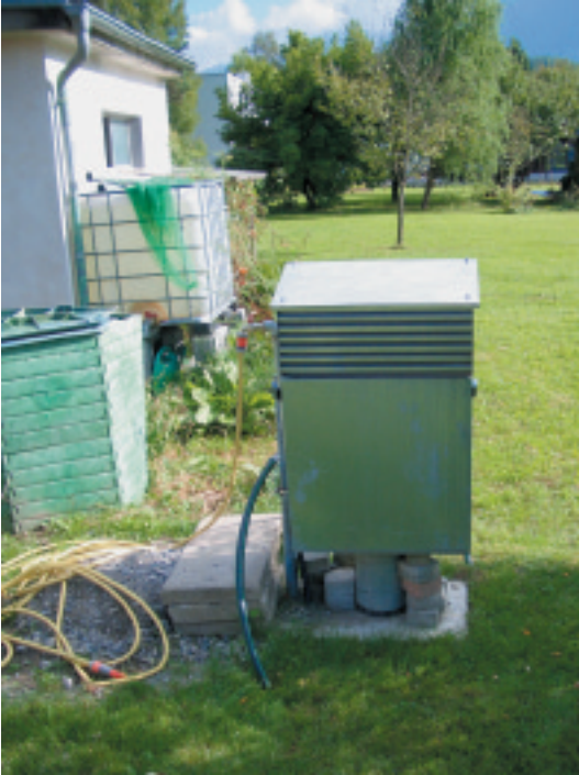
Indtrækskanal til jordkanal, der forvarmer luften til huset
