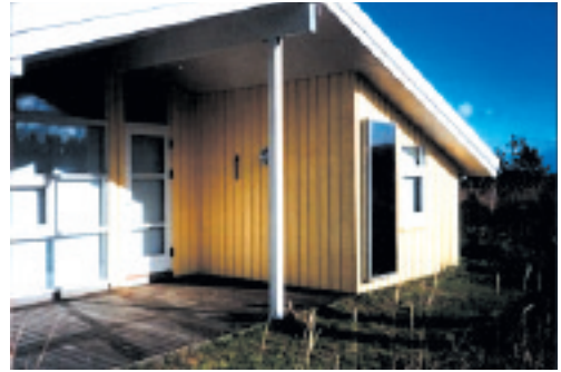
Eksempel - Aids solfanger med solcelle til udluftning af sommerhus mod fugt
