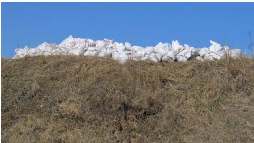
Foto 9: Den polske radiostation RMF har på sin hjemmeside lagt dette billede ud, der viser, at man har lagt sandsække langs kanten på gyllelagunen ved den danske svinefarm ved byen Kujnanki for at forhindre, at gyllen skal sive ud og ødelægge det grundvand, der forsyner 300.000 indbyggere i Bydgoszcz med rent vand.
