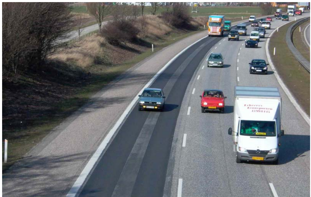
Figur 3. Forsøgsstrækningen med den oprindelige ABS belægning. Oprettningen med koldasfalt af hjulsporene i den højre vognbane ses som mørke striber.
