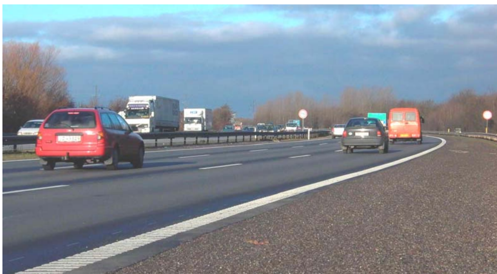
Figur 2. Foto fra forsøgsstrækningen ved Solrød.
