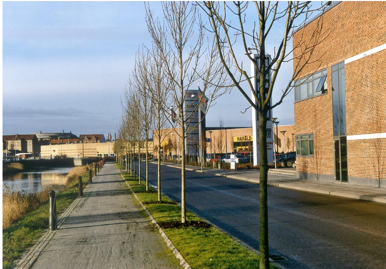
6.9. Området langs Bygholm Å omlagt med nyt fortov og cykelsti med træbeplantning
