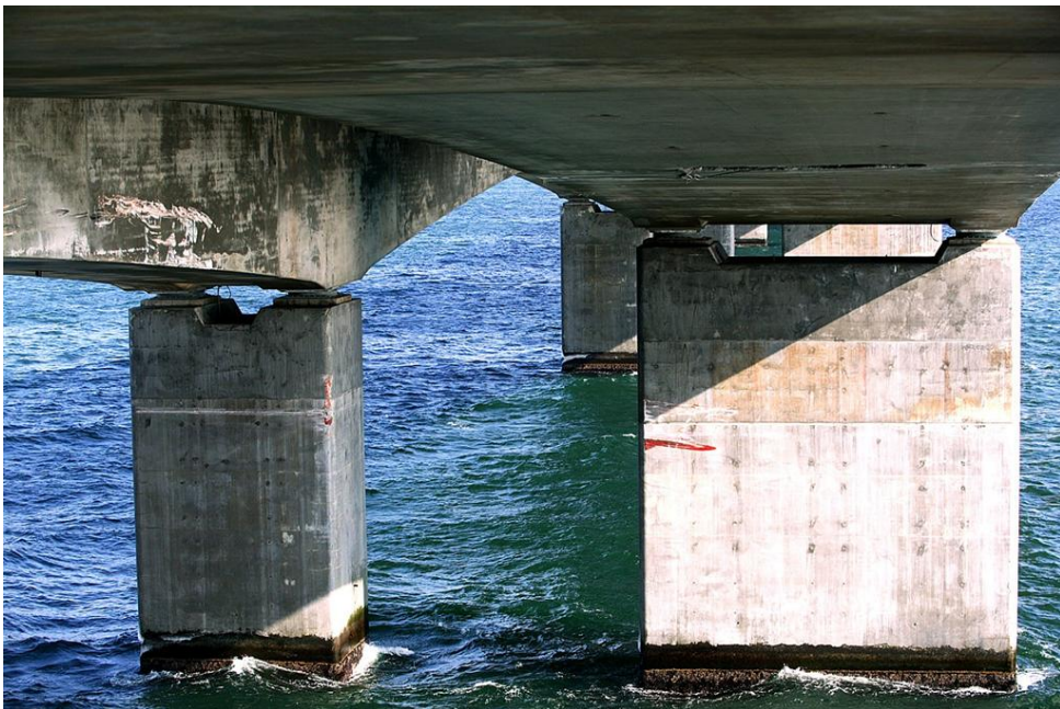
Vestbroen pille nr. 52 med motorvejssektionen til højre og jernbanesektionen til venstre.
