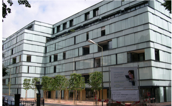
90 Minergie-P lejligheder à 120m 2 + kæmpe kontor/butiksareal i nederste underetage + parkeringskælder i 2 etager. I alt ca. 17.000m 2 Winterthur Let/tung konstruktion Arkitekt : Senn Architektur AG, Senn-BPM. Opført 2004/2005
