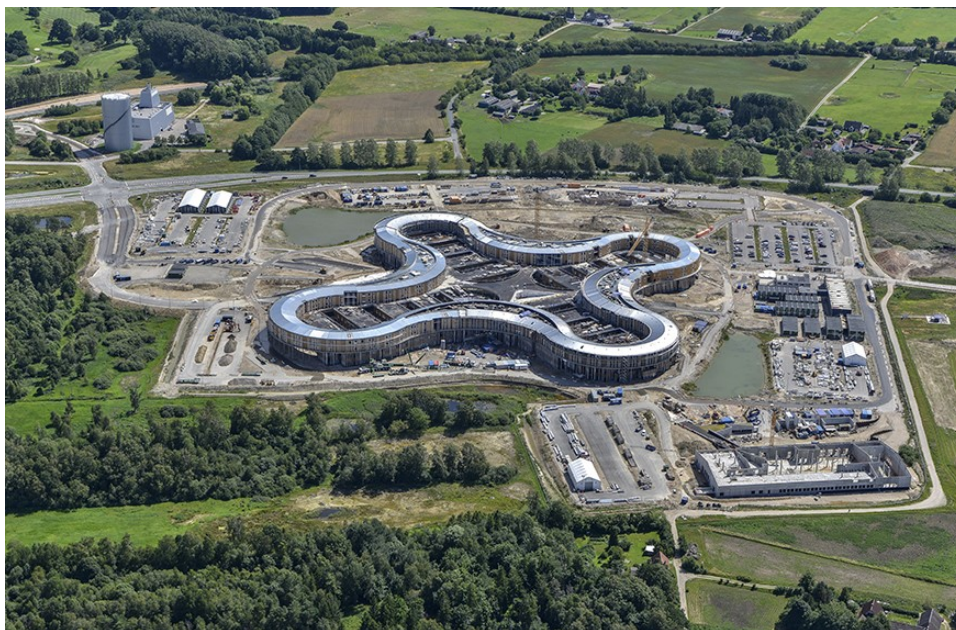
Byggeplads for Nyt Hospital Nordsjælland, juli 2023.
