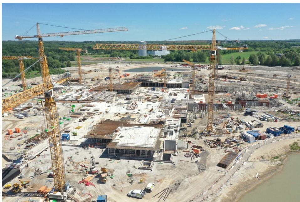
Byggeplads for Nyt Hospital Nordsjælland, juni 2021.
