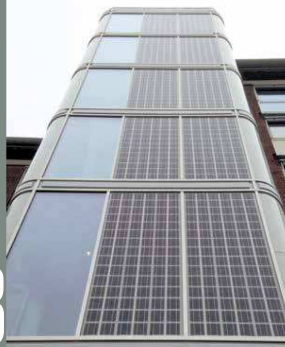
ELEVATORTÅRN MED FACADEINTEGREREDE SOLCELLER, DANSK ENERGI PÅ FREDERIKSBERG
