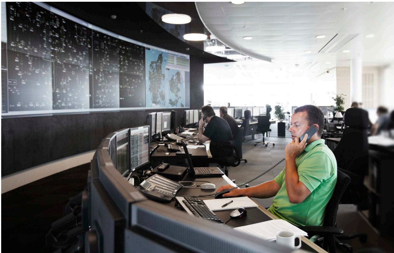
KontrolCenter EL i Erritsø.
