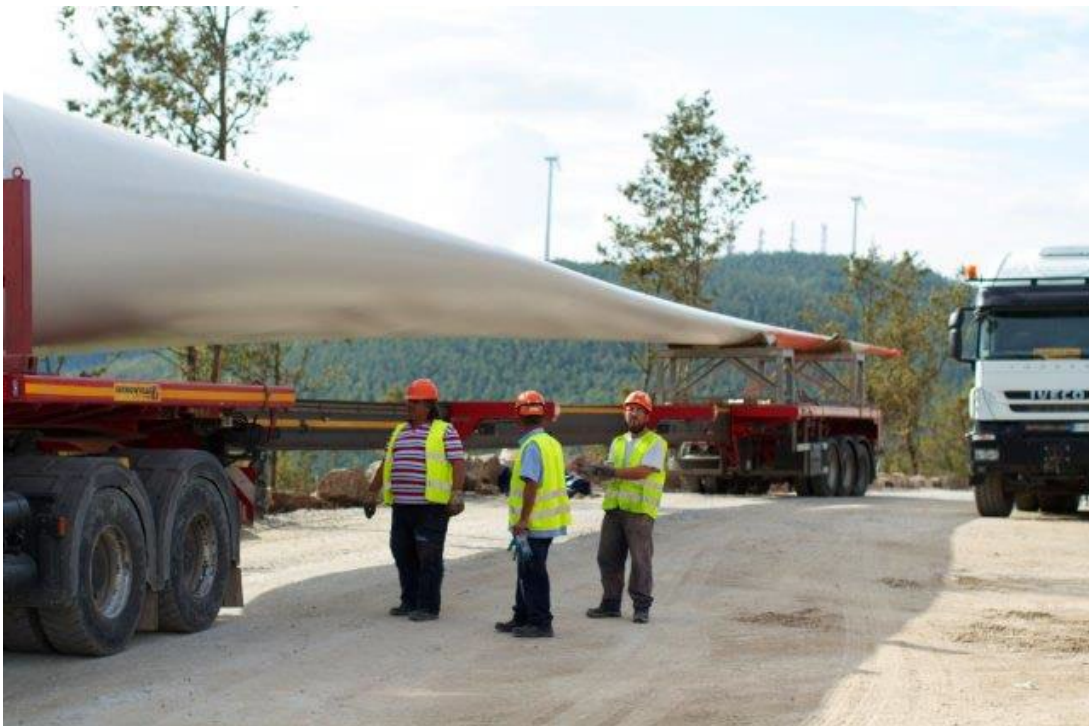
European Energy – italiensk vindenergi-park under opførelse
