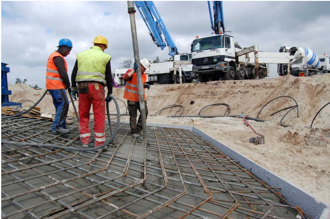
European Energy - støbning af fundament i dansk vindenergi park
