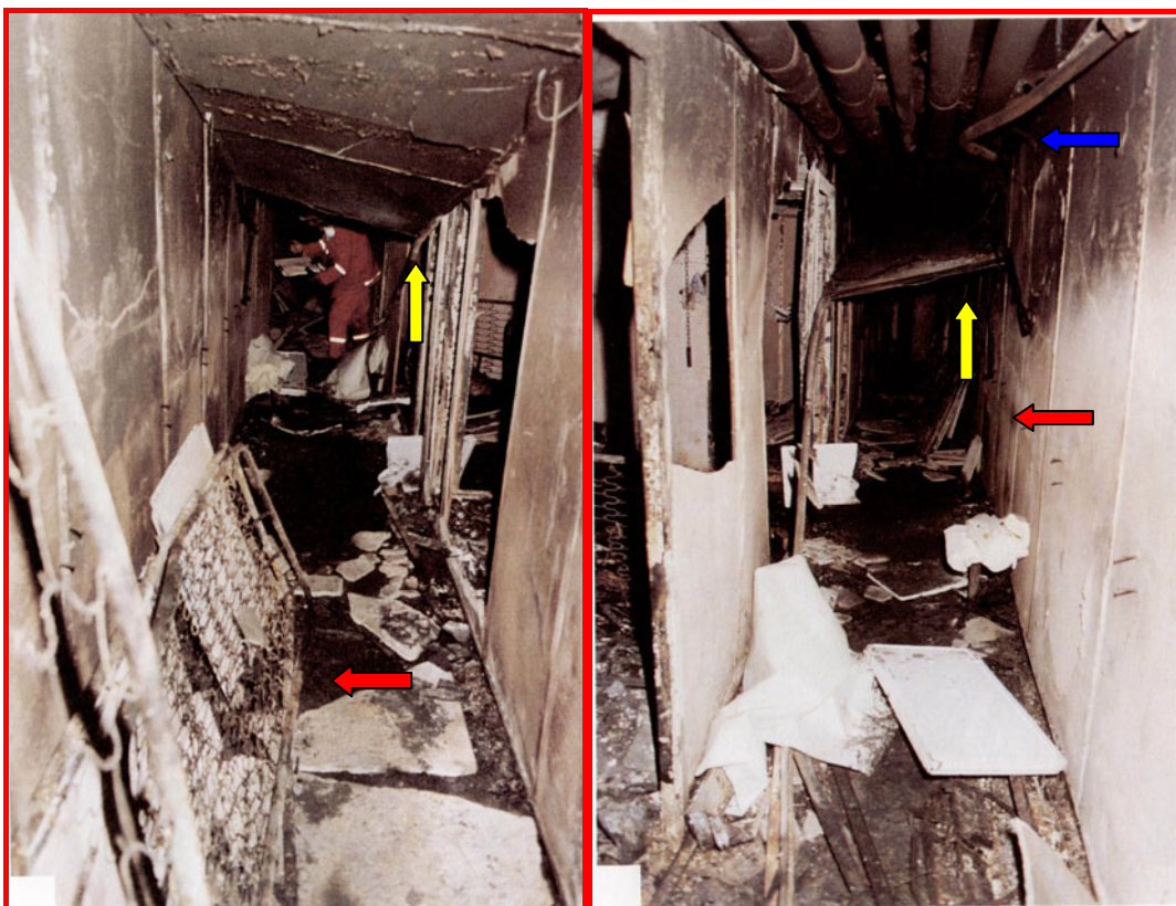
Figur 11. De två bilderna visar platsen för uppkomst av brand nr 3 (Hydraulbranden). På dessa bilder syns den säng (markerad med röd pil) som sannolikt har använts för att antända hydrauloljan. Blå pil markerar aktuellt hydraulrör, se även Figur 12. De övriga rören som är förlagda i samma taksektion som det läckande hydraulröret är ej synbart brandpåverkade. Notera att undertaksstrukturen som innan branden täckte hela rörstråket är sönderbruten och hänger ned (markerat med gul pil) i korridorens längdriktning.
